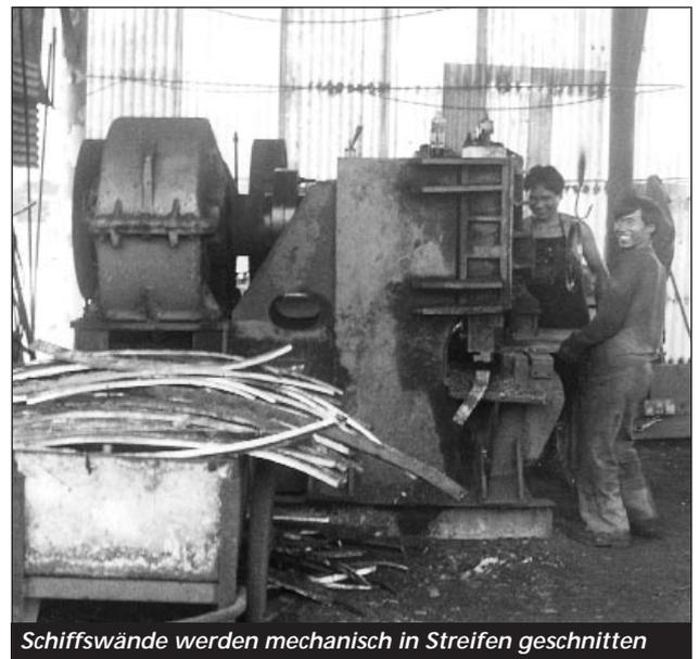
*Schiffswände werden mechanisch in Streifen geschnitten*
